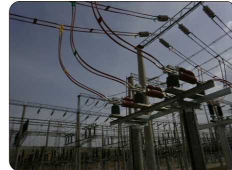
(d) 户外使用：应用于发电机出口、升压变低压侧
