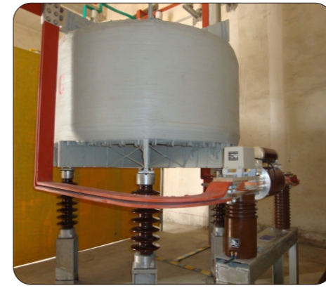
(b) 户内使用 (分散布置：旁路限流电抗器)
