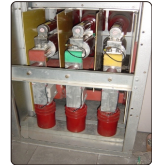
(c) 户内使用：安装于GG1A柜或KYN28柜，构成DGXK2大容量告诉开关装置
