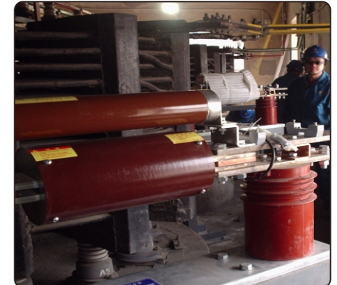
(b) 户内使用 (分散布置：旁路限流电抗器)
